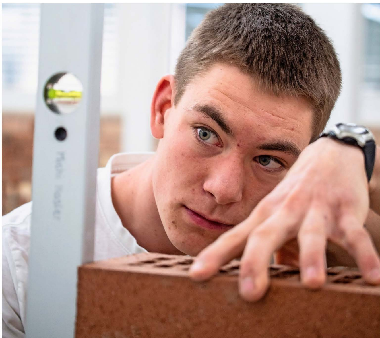
Jeder Backstein muss sitzen: Beim Mauern achtet Michael Hasler auf exakte Arbeit. Foto: PD
