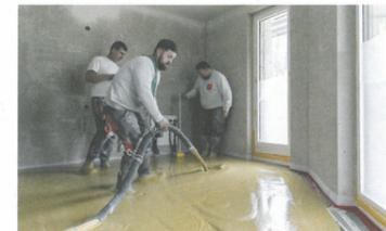
**IN DEN MEISTEN DER UNTEREN WOHNUNGEN** wurde bereits der mineralische Gussboden gegossen. Bis der Boden betreten werden kann, braucht es anschliessend mehrere Wochen – trotz unterstützender Wirkung der Bodenheizung. Foto: MF
