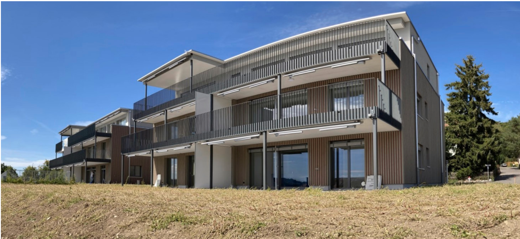
Gegen Süden ausgerichtete Hanglage mit toller Aussicht: An der Frobergstrasse entstanden zehn moderne, lichtdurchflutete Eigentumswohnungen.
